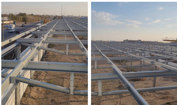
Рисунок 2 – Монтаж конструкций покрытия
